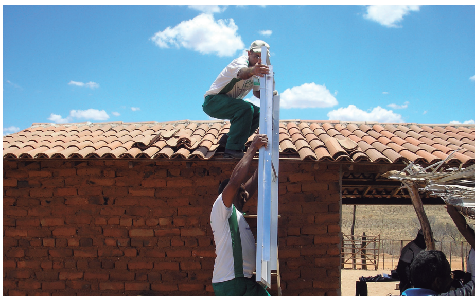
Figura 31 – Instalação do painel solar no município de Casa Nova-BA
