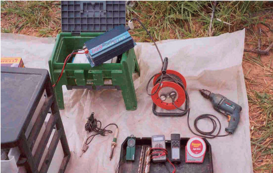
Figura 28 – Ferramentas utilizadas para instalação dos SIGFI Fonte: Coelba
