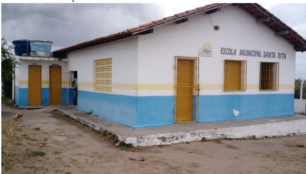
Foto n. III – Escola Municipal Santa Rita Fonte: Cleves de Oliveira Serra, 2017.
