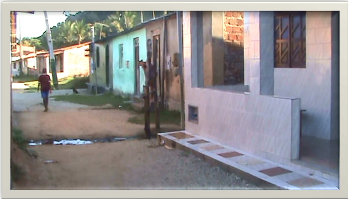
Foto 3 – Fachadas das casas
