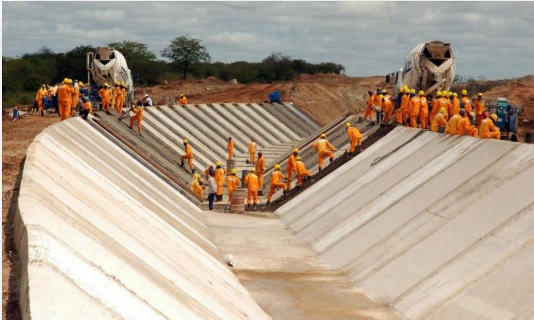
Figura 9. Trecho da Obra eixo Norte.
