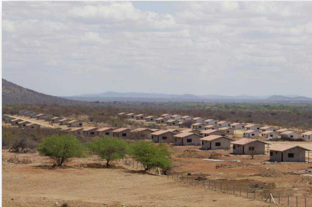
Figura 13. Vila Produtiva construída ao lado da Aldeia Truká, Território Reivindicado Pelo Grupo.
