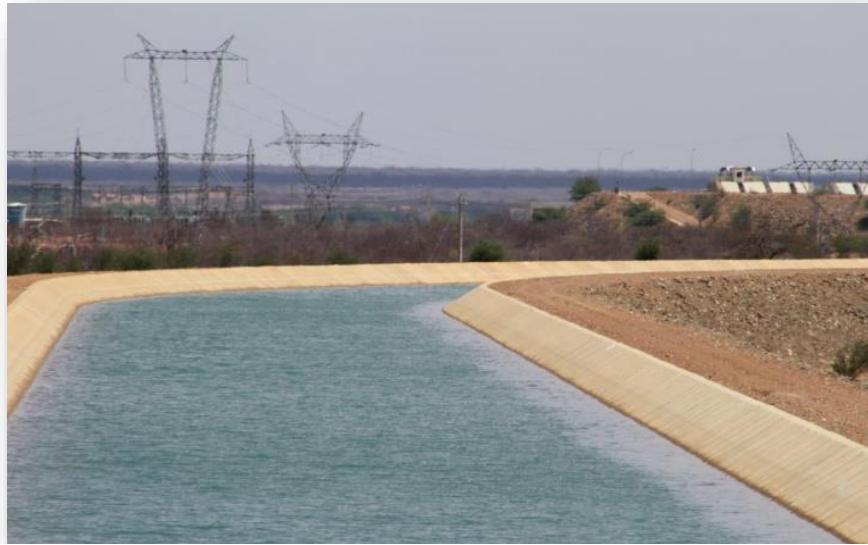
Figura 7. Trecho da obra Eixo Norte situado ao lado da Aldeia Truká.
