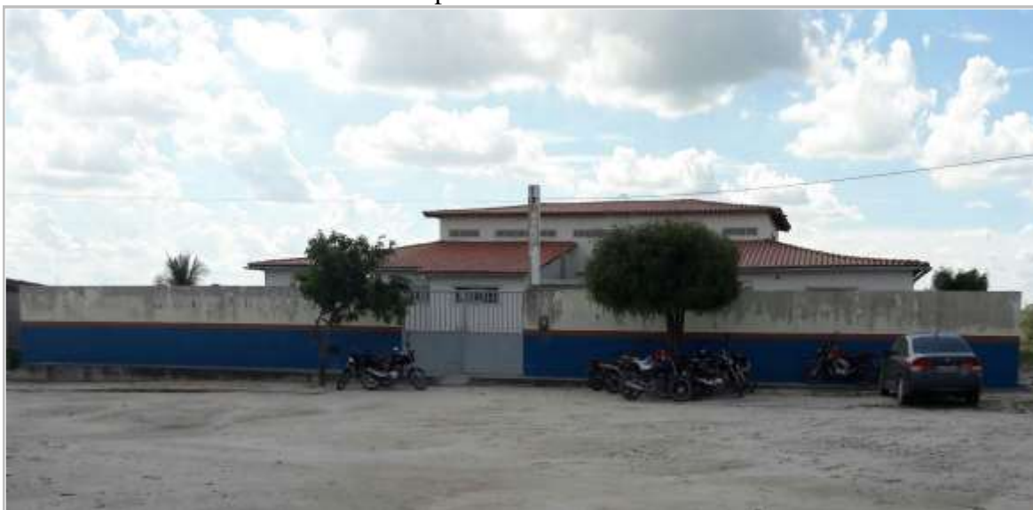
FOTO 02: Fachada da Escola Municipal Salvador Correia de Oliveira
