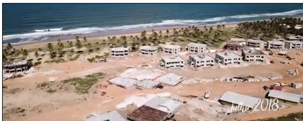
Figura 19 – Construção do Empreendimento Ponta de Inhambupe ano 2017. Fonte: Site oficial Prima Empreendimentos.
