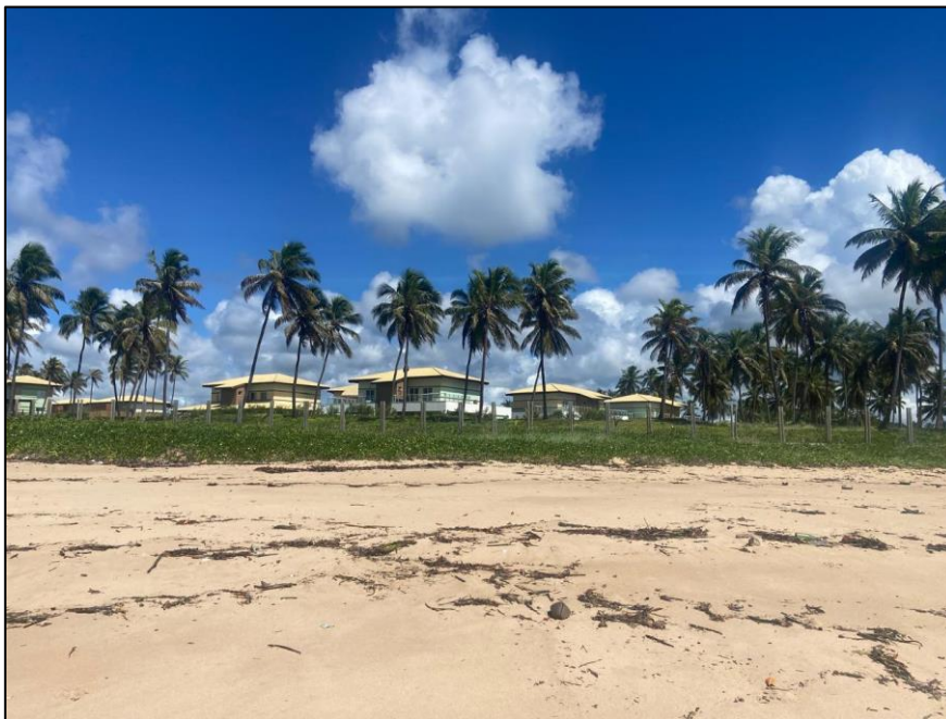
Figura 39 - Privatização da área de praia por equipamento hoteleiro Ponta do Inhambupe. Fonte: Registrada pela autora em visita de campo, 2024.
