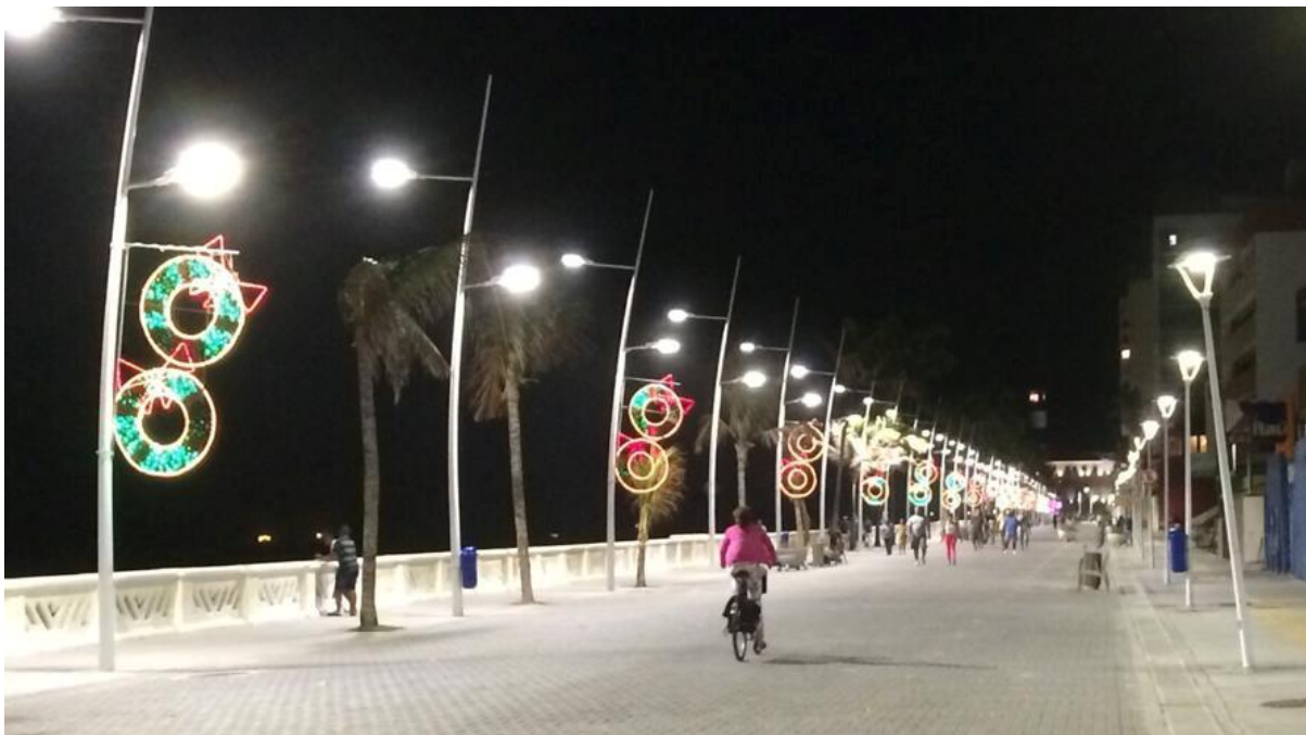
Figura 3.6 – Iluminação pública no trecho da orla da Barra, Salvador - BA
