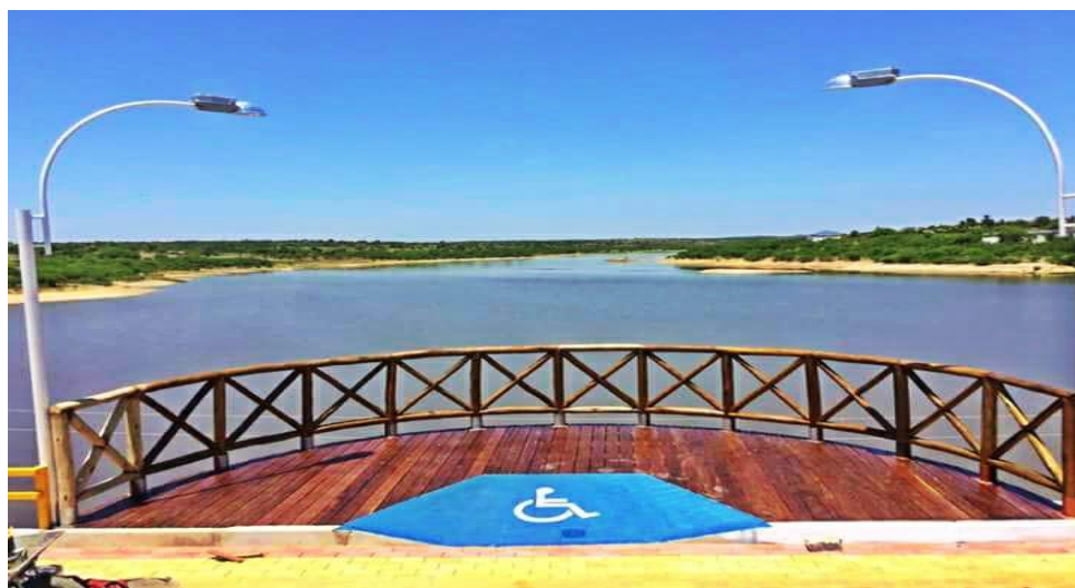
Figura 05: Vista parcial do Açude de Valente - 2017
