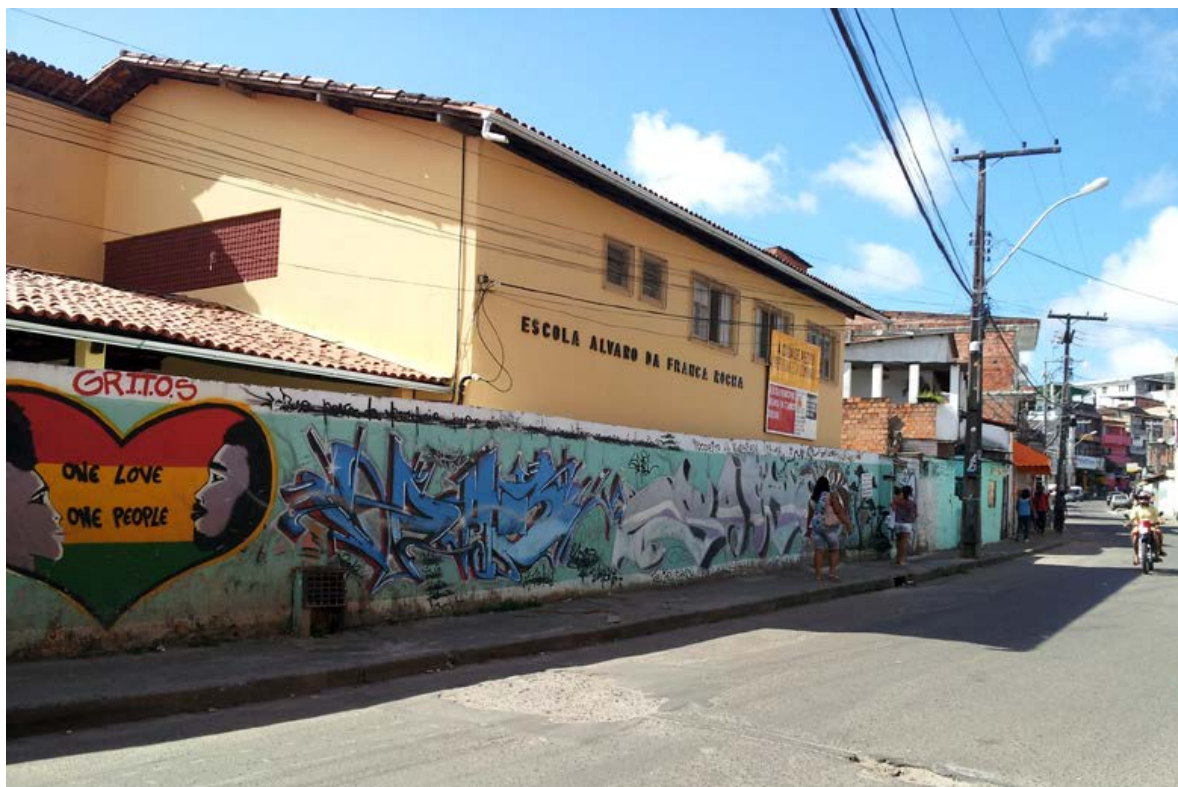
Figura 18: Fachada da Escola Álvaro da Franca Rocha Fonte: Arquivo da Autora
