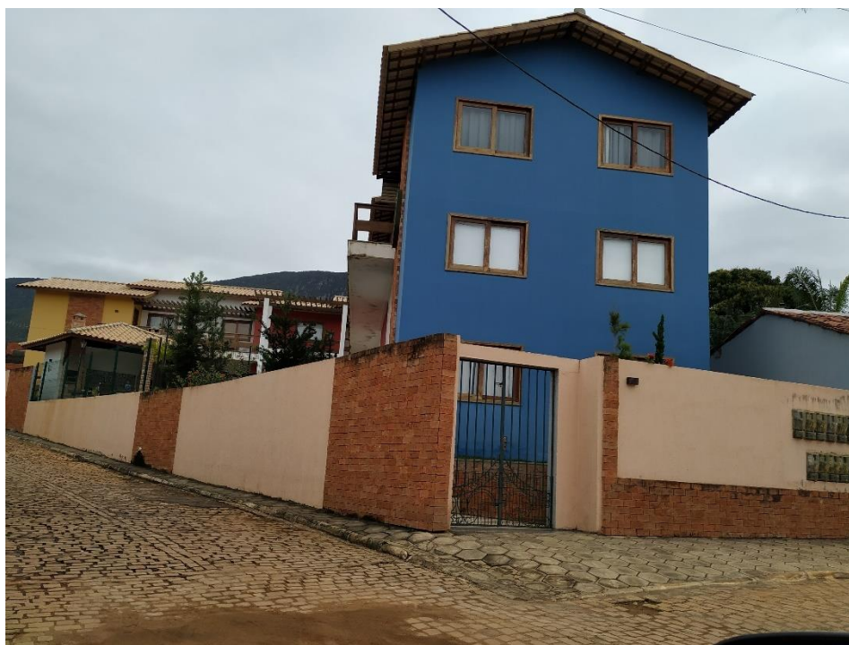
Figura 5 - Fotografia que evidencia a mudança estrutural de imóveis na vila de Itaitu
