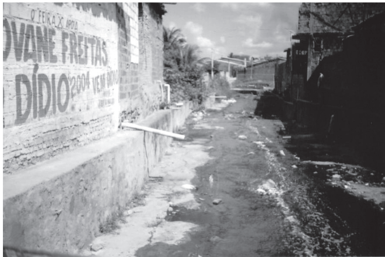
Figura 5 – Diversos tubos de PVC dispendo dejetos no riacho canalizado - Conjunto Feira X - Feira de Santana - BA
