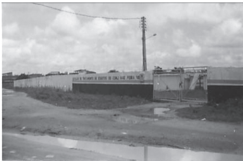
Figura 2 – Estação de Tratamento de Esgoto (frente)
