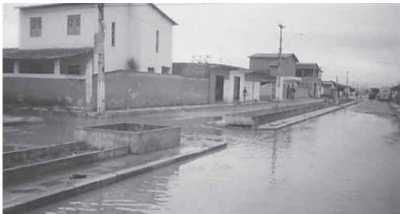
Figura 4 – Rede de Captação de Águas Pluviais – Alagamento Fonte: Adriano Santos e Fernanda Santos, maio 2002.
