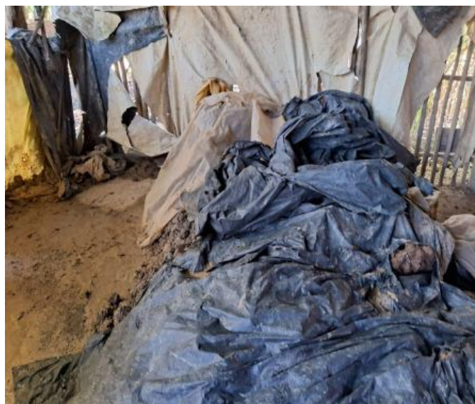
Figura 07 - Barro coberto para ajudar a manter a umidade
