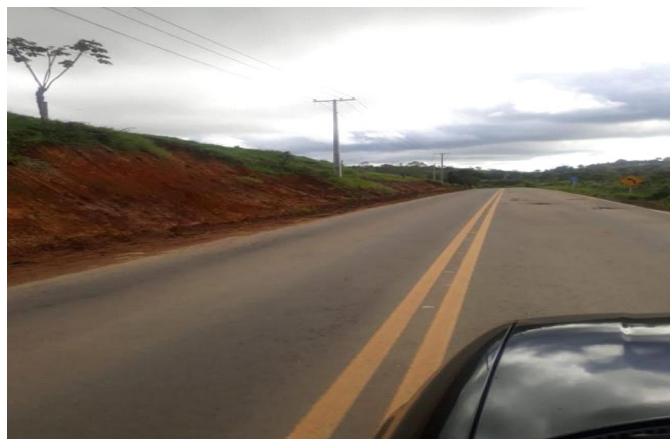
Figura 8- sinalização no trecho próximo da localidade do Barro.
