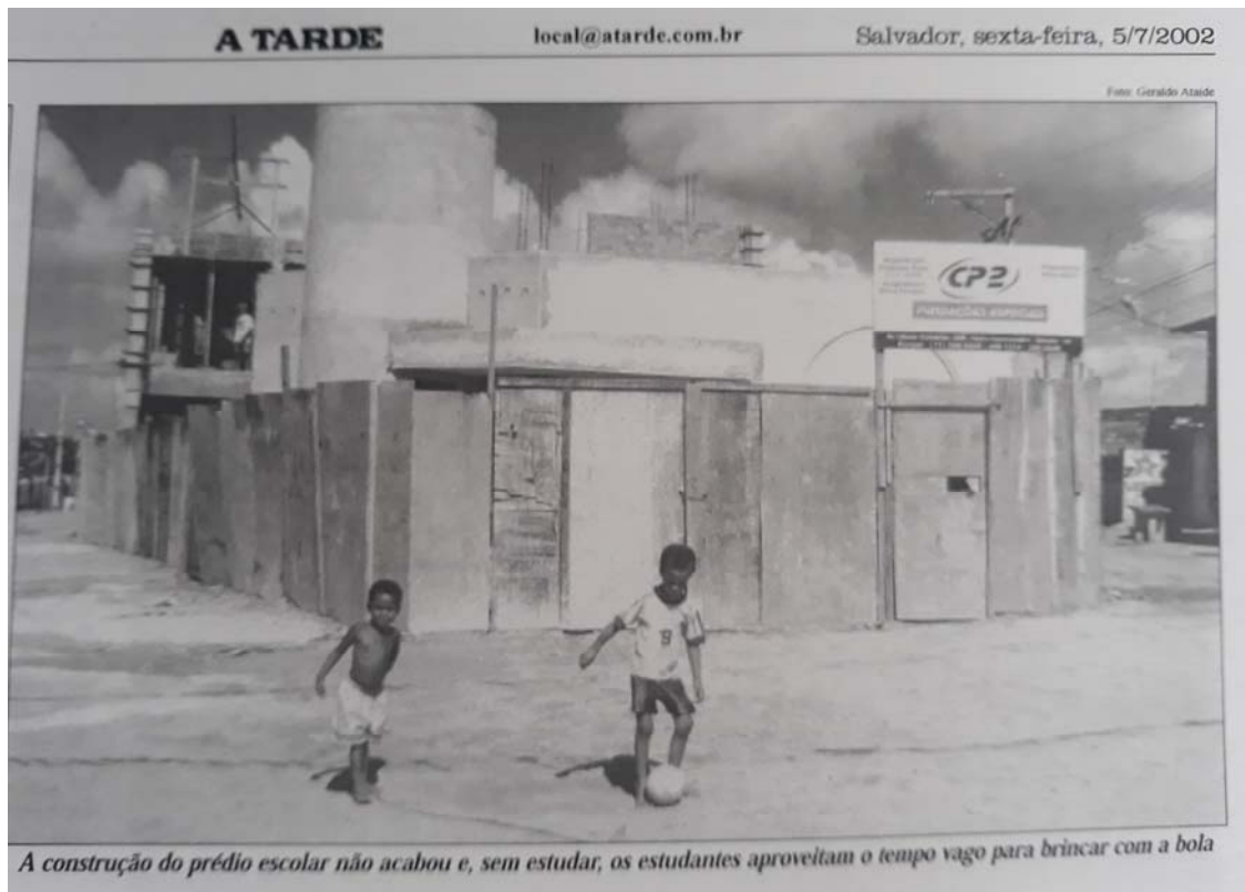
IMAGEM 4 : Escola Nova em Construção, 2002.
