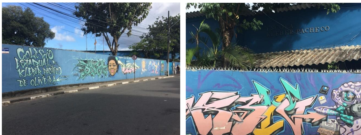
Figuras 23 e 24 – Fachada da Escola Estadual Kleber Pacheco
