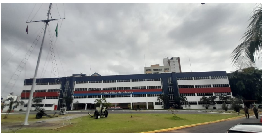
Figura 47 – Pátio Dois de Julho do CMS
