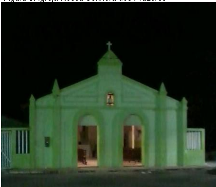
Figura 6: Igreja Nossa Senhora dos Prazeres
