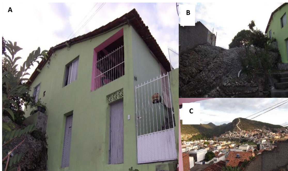
A – Frente da residência; B- Entorno da residência; C – Vista da residência Fonte: Autora (2016). 2016.
