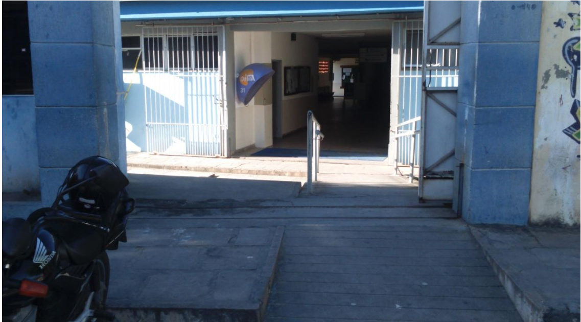
Imagem 2: Rampas de acesso para deficientes
