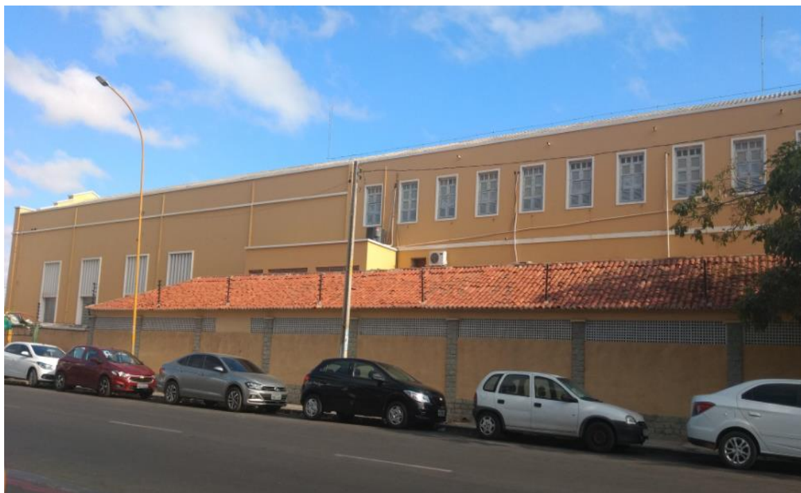
Imagem 3- Lateral do CNSA, lado da Av. Guararapes.
