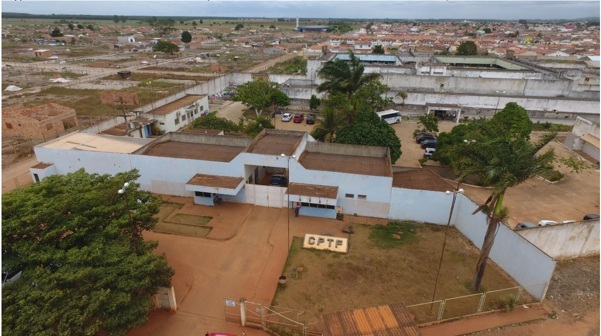
Figura 1 – Vista de cima do Conjunto Penal Teixeira de Freitas – Bahia, 2019.
