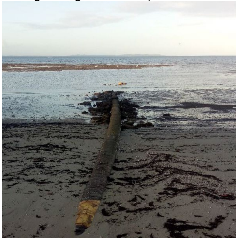
Figura 3 - Passagem do gasoduto na laje do machadinho em Cairu
