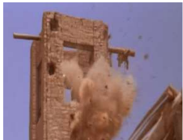
Figura 18-Torre atingida por bala de canhão
