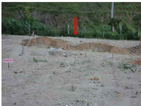
Figura 02: Terreno próximo ao fundo de vale, sendo preparado para a construção de casas. Fonte: Visita técnica, Novembro de 2011.
