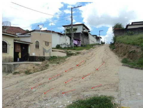
Figura 03: Canais de escoamentos superficiais concentrados, esculpidos em arruamento ao longo de declives do terreno no Bairro Maria Preta na cidade de Santo Antônio de Jesus. Fonte: Visita técnica, Novembro de 2011.
