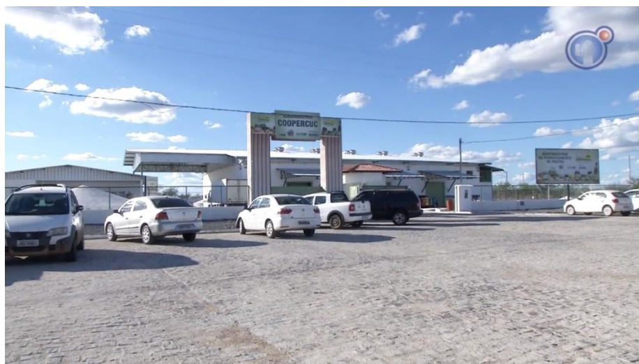
Figura 44 – Ambiente externo da agroindústria da Coopercuc
