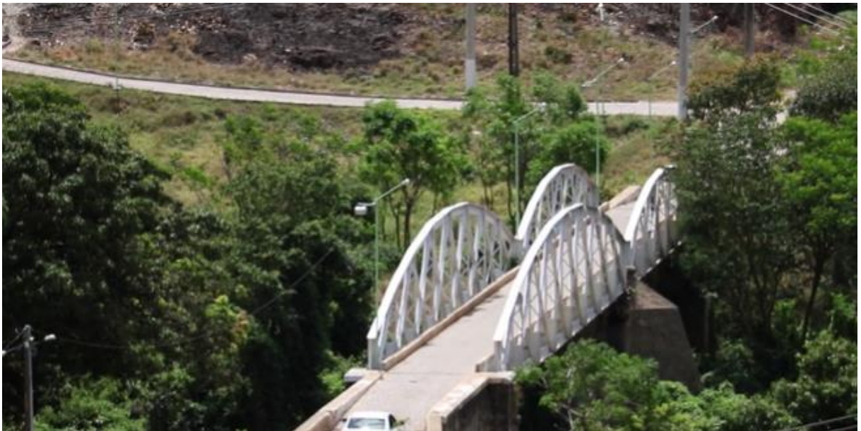
Figura 5 – Pontilhão do Rio Itapicuru
