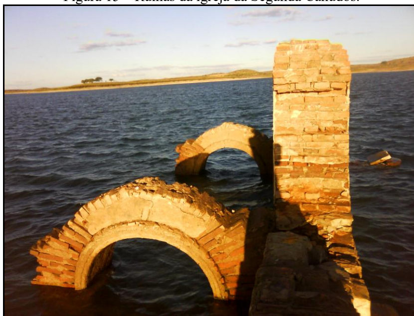
Figura 15 – Ruínas da igreja da Segunda Canudos.
