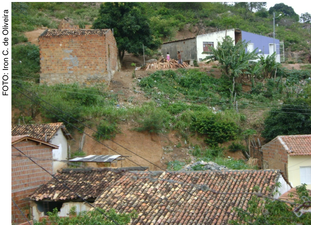
FIGURA 8: Imagem de residências próximas às encostas do bairro da Serrinha.
