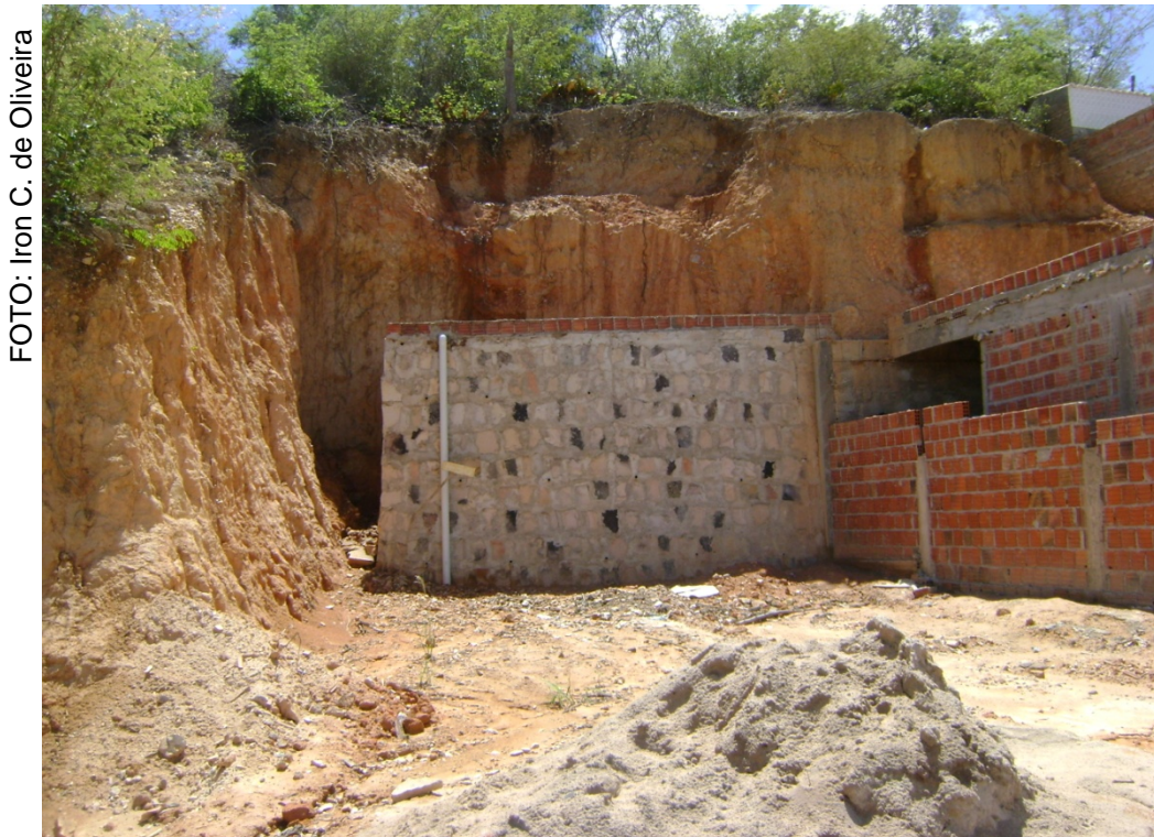
FIGURA 12: Construções por meio de taludes de corte no bairro Mundo Novo.
