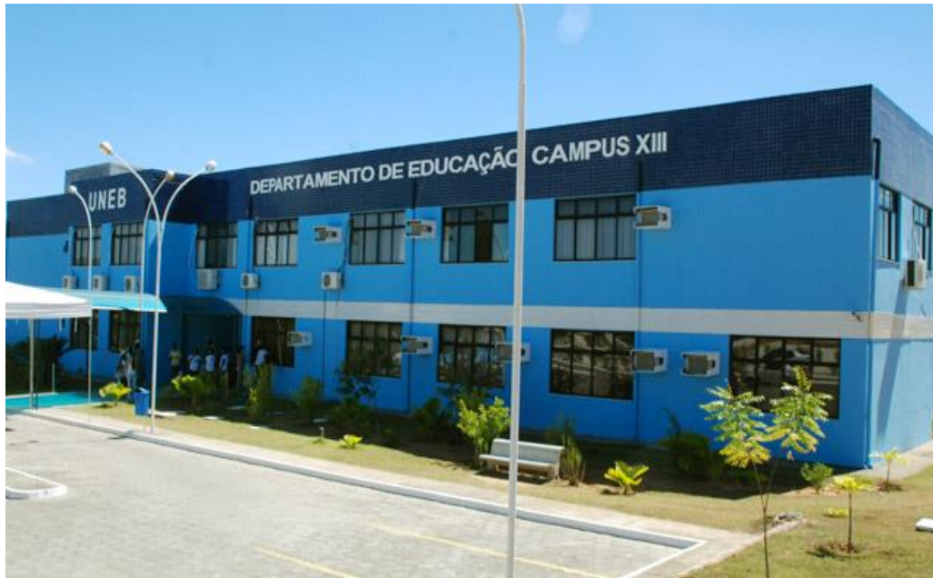
Figura 2. Fotografia da fachada do DEDC do Campus XIII da UNEB
