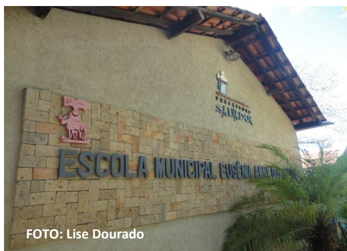
Figura 05 – Fachada principal da Escola Municipal Eugênia Anna dos Santos.
