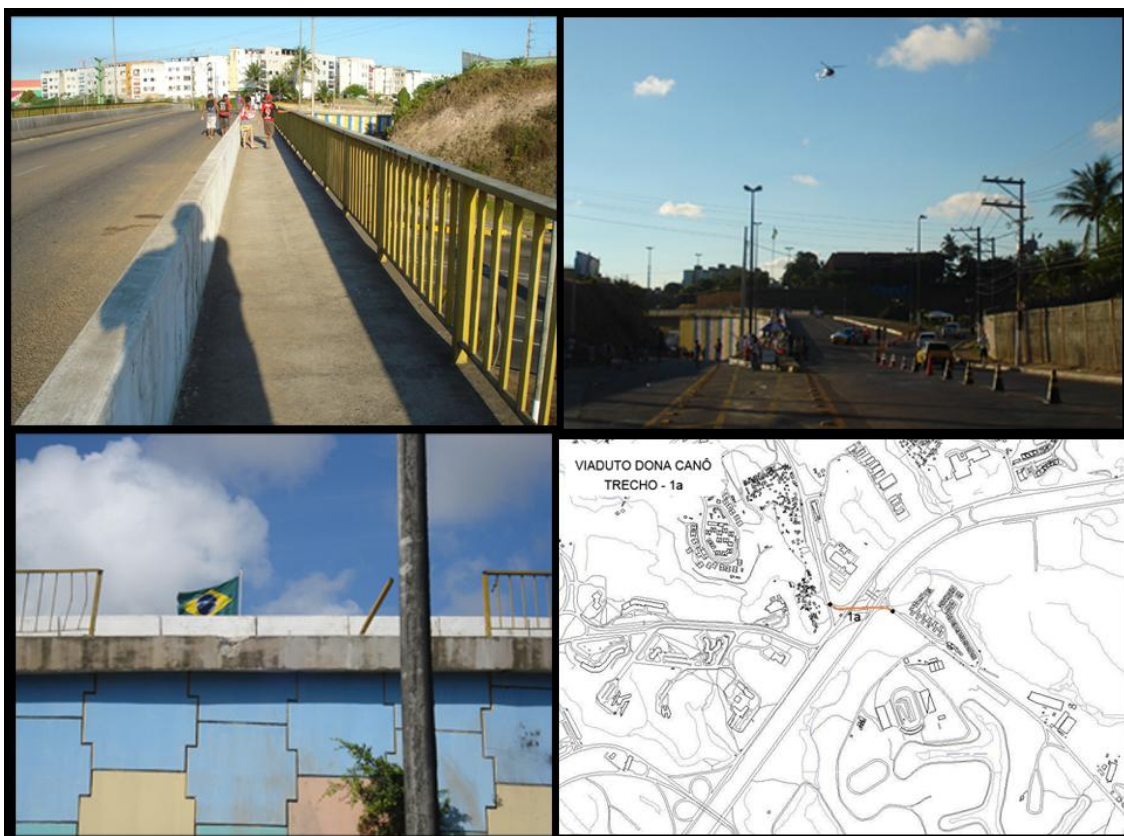
Figura 29: Imagens do trecho “1a” (Viaduto Dona Canô) e sua localização no conjunto da área de estudo.
