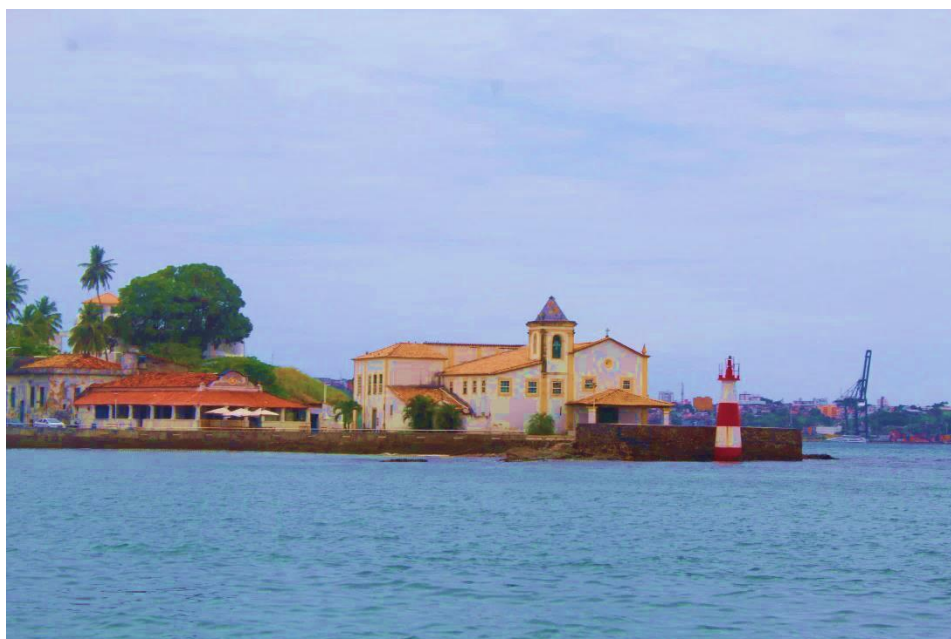
Foto 2 – Igreja de Nossa Senhora do Monte Serrat
