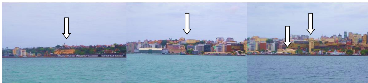
Foto 13 – Santo Antônio Além do Carmo ao Elevador Lacerda
