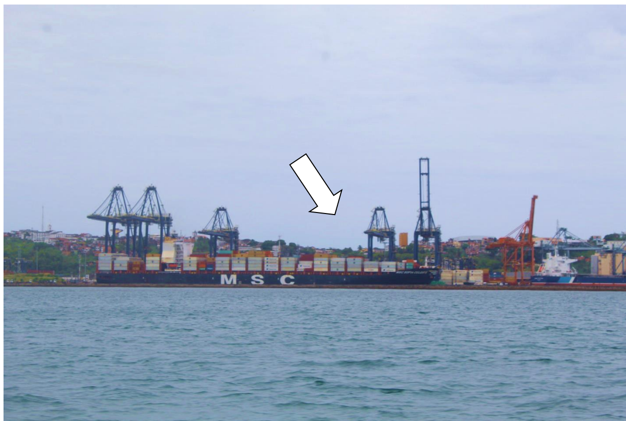
Foto 11 – Estruturas do Porto de Salvador
