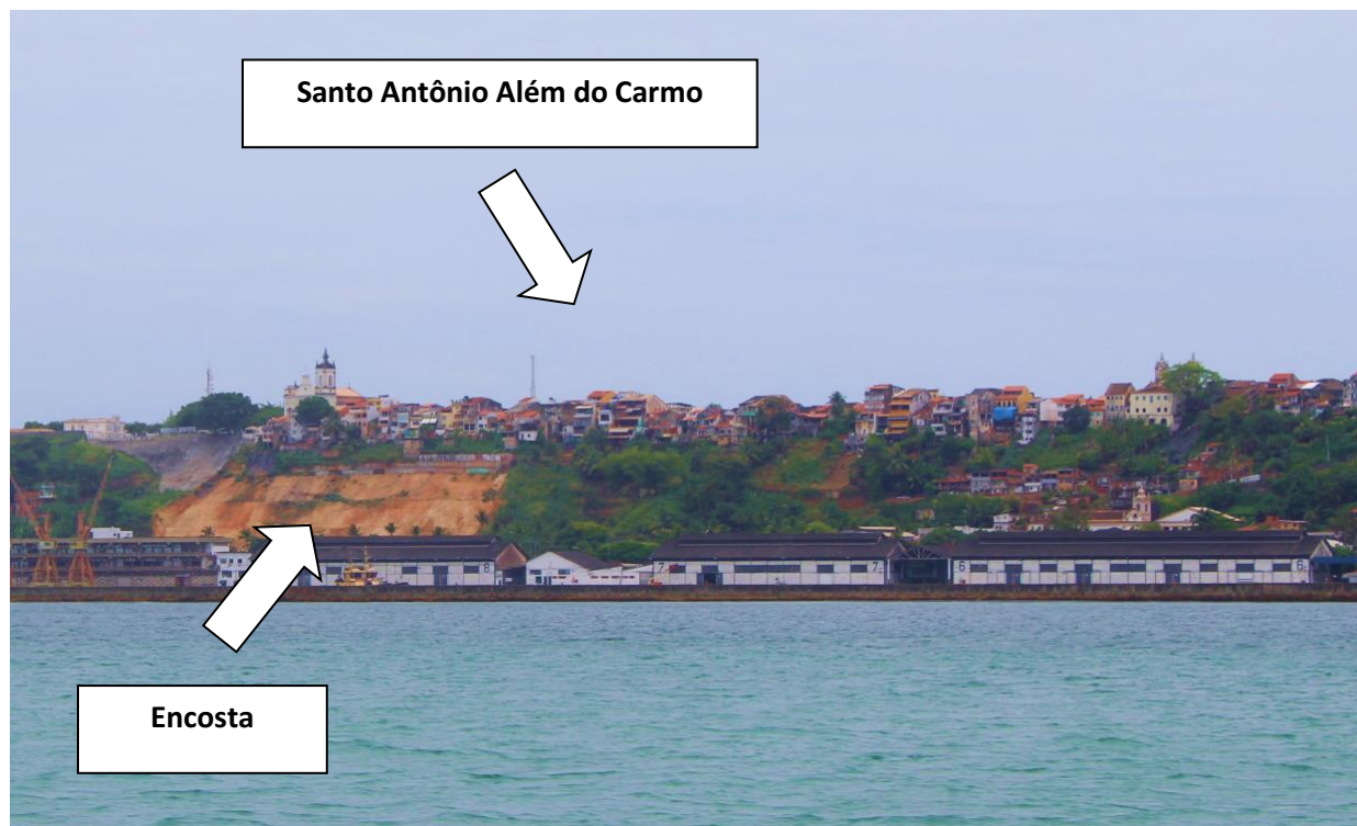
Foto 14 – Bairro Santo Antônio Além do Carmo e encosta com intervenção.
