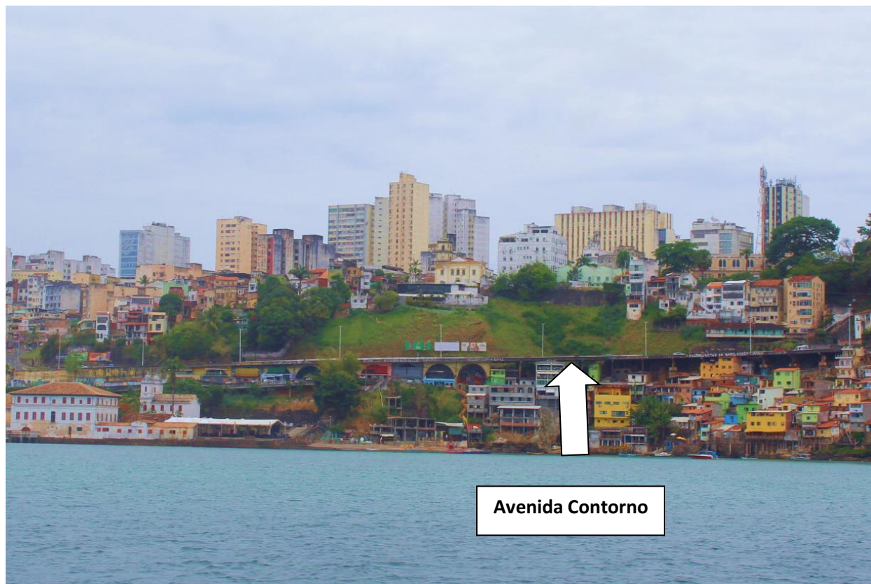
Foto 23 – Avenida Contorno na falha geológica baiana.
