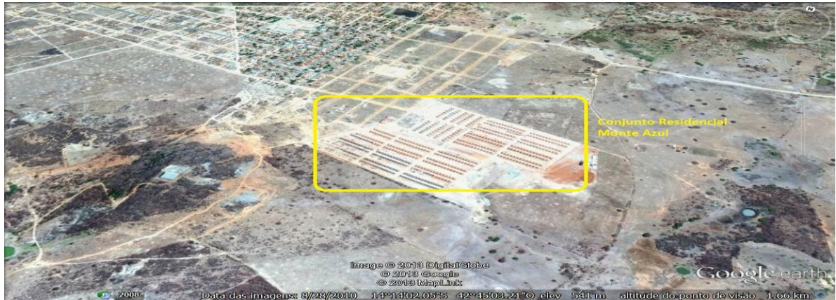
Figura 2: Imagem de satélite de localização Conjunto Residencial Monte Azul Fonte: Adaptado de Google Earth.
