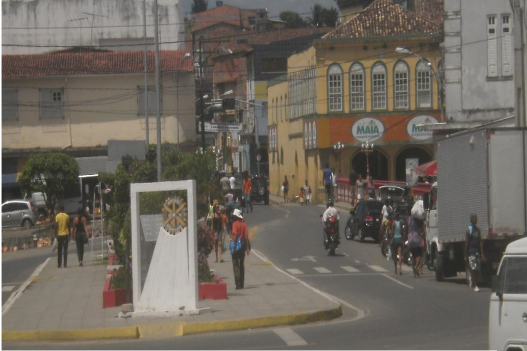
Figura 11 – Barreiras na calçada obrigam os pedestres a andar pela via de veículos.
