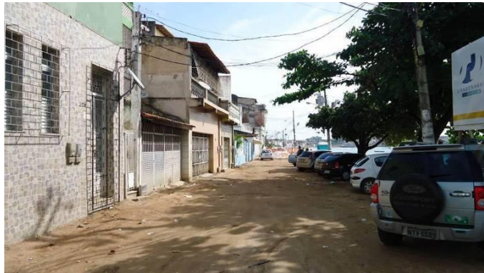
Figura 13 – Avenida Beira Mar (trecho em obras)
