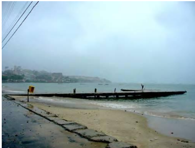
Figura 4 – Ponte do Crush
