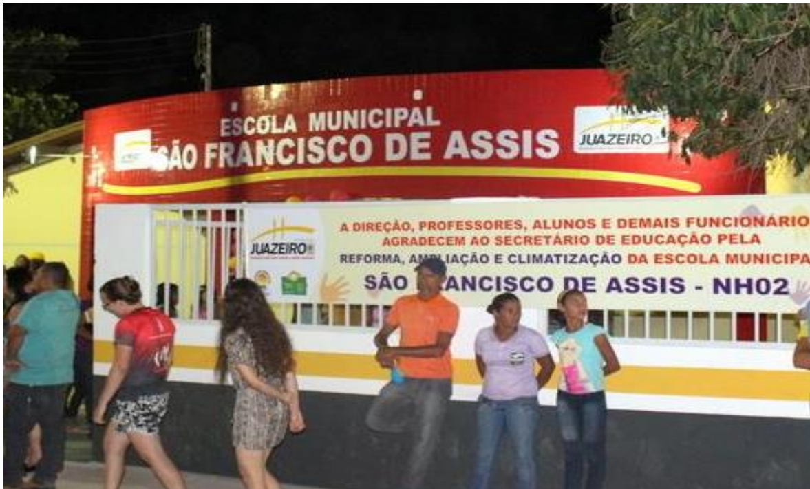
Figura 07 – Fachada de Entrada da Escola Municipal São Francisco de Assis
