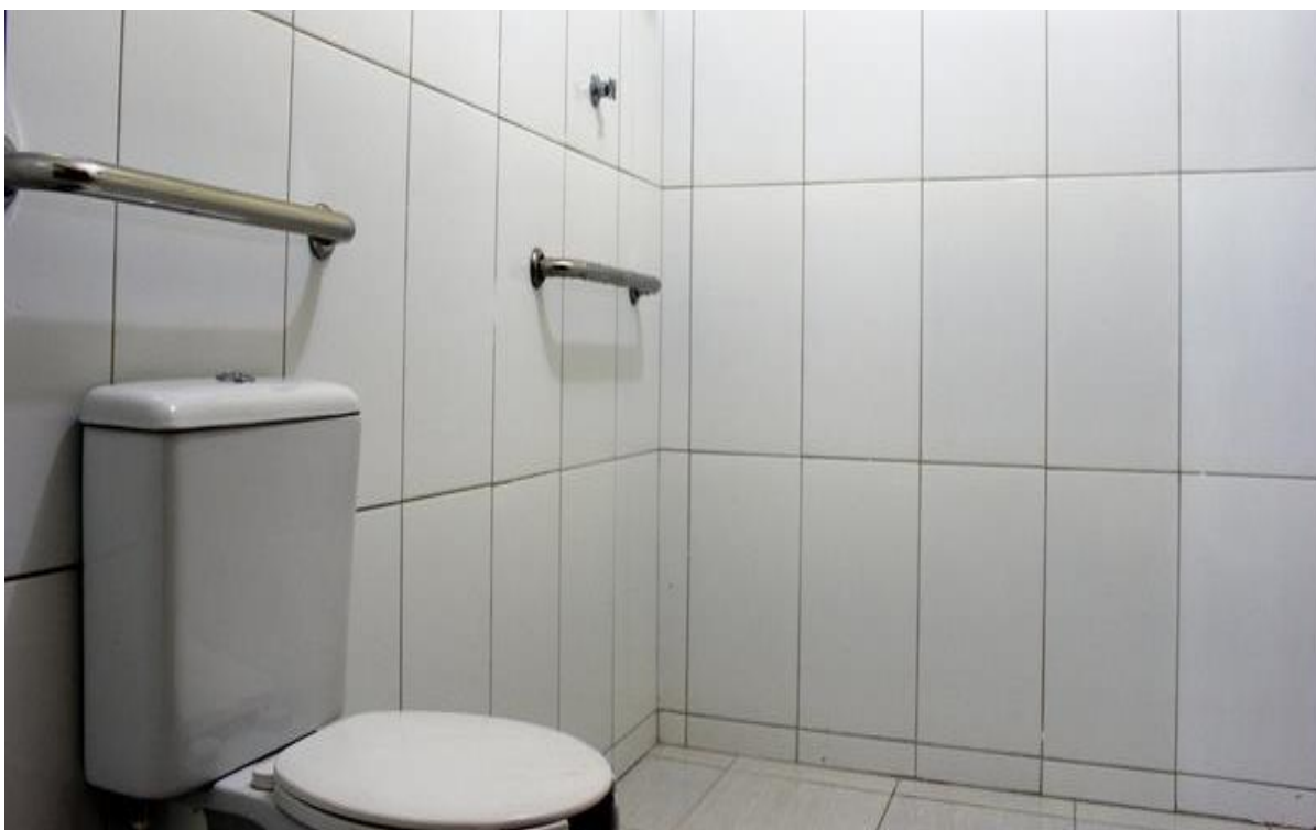
Figura 10 – Banheiro Adaptado da Escola Municipal São Francisco de Assis
