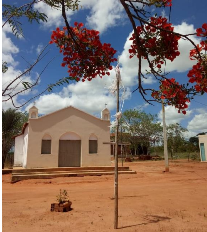
Figura 12: Segunda igreja construída
