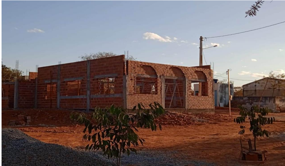
Figura 13: Terceira igreja em construção
