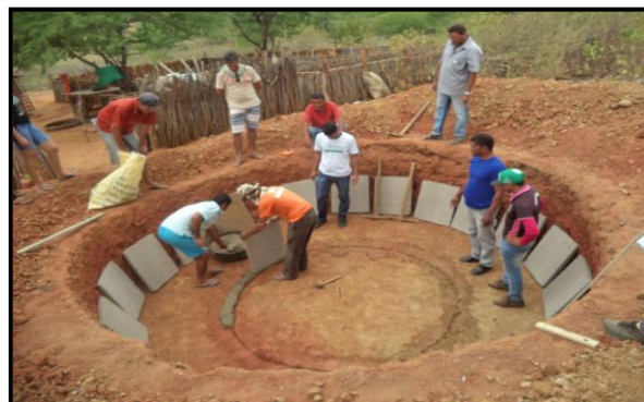
Passo 1: nivelamento do solo e construção das paredes
