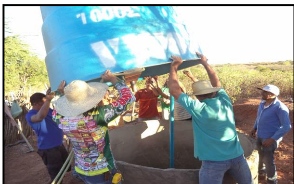
Passo 3: Colocação da caixa d'água
