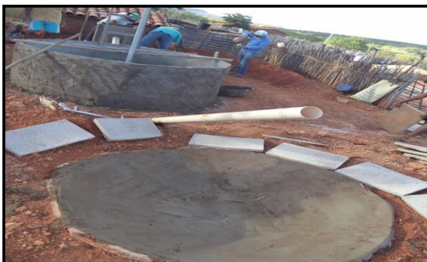
Passo 1: nivelamento do solo e construção das paredes
