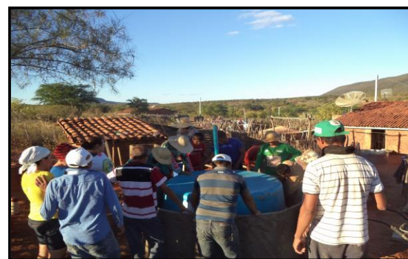
Passo 3: Colocação da caixa d'água
