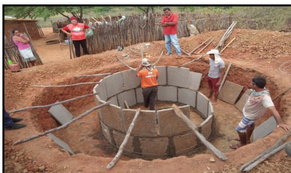
Passo 3: Colocação da caixa d'água
