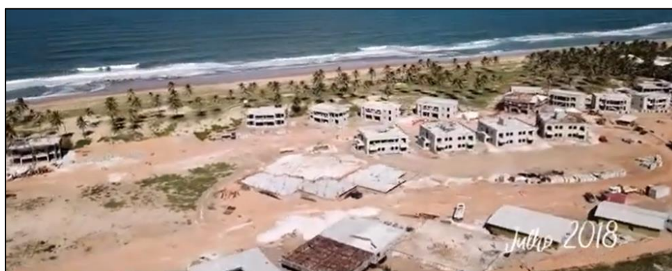
Figura 22 – Construção do Empreendimento Ponta de Inhambuê ano 2017. Fonte: Site oficial Prima Empreendimentos.
