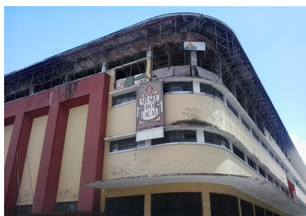
Figura 7: Fachada do prédio que abriga o Museu do Cacau Fonte: Foto da Equipe
