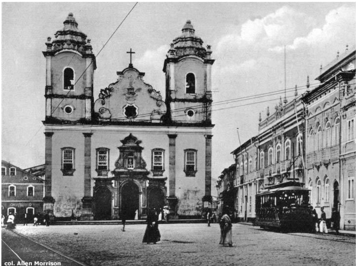
Figura IV – Igreja de São Pedro em 1907 (Futura Avenida Sete de Setembro)
