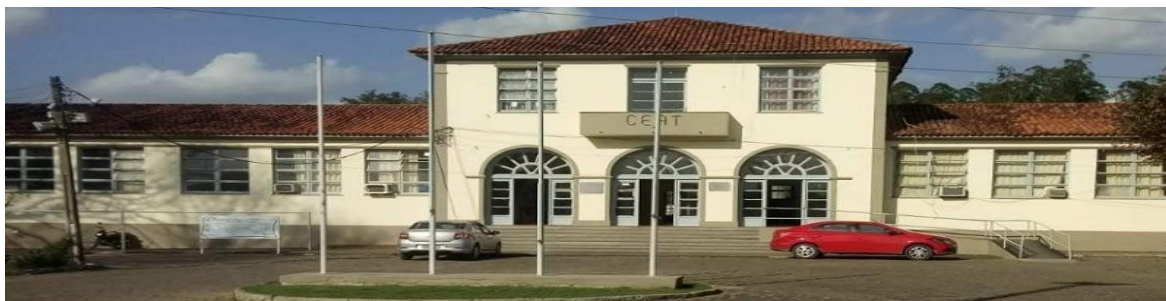
Figura 07 – Imagem do CETEP Recôncavo II
