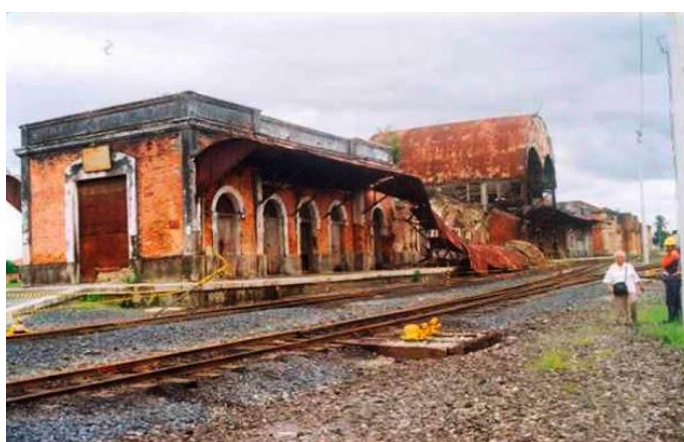
Figura 2 – Estação Ferroviária São Francisco
