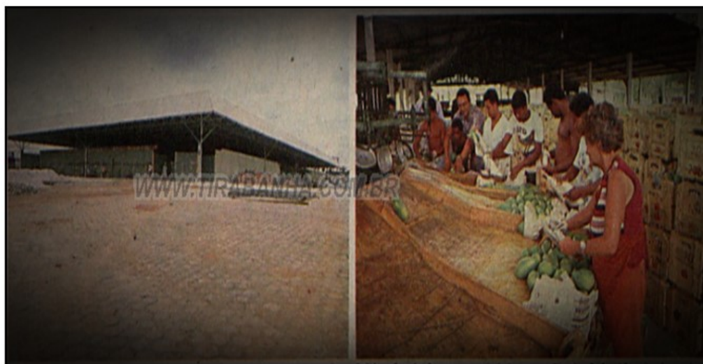
Figura 5: Centro de Abastecimento – parte externa e interna (1988) 33 .
