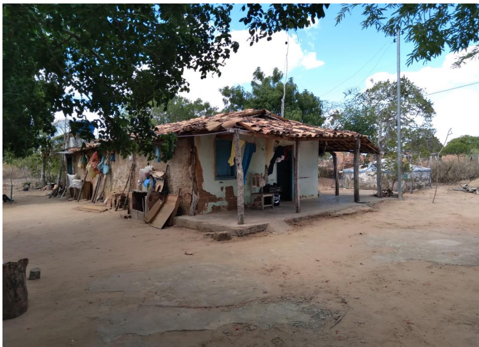
Figura 8: Casa de adobe no povoado do Topo.
