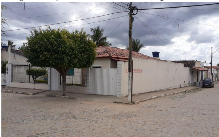
Figura 6: Subprefeitura no distrito de Pataíba, Água Fria/BA.
