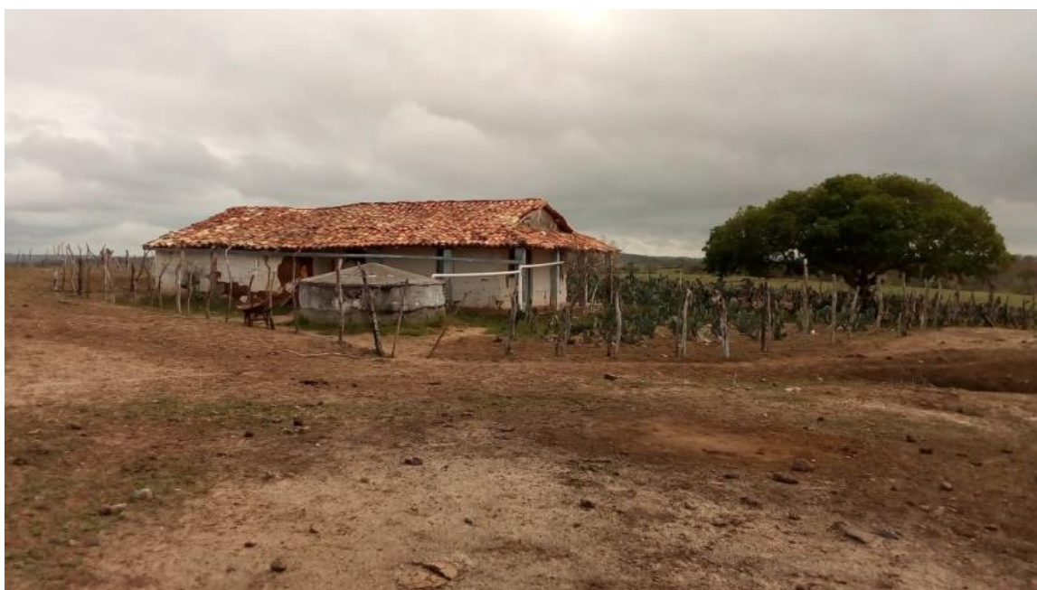
Figura 11: Casa principal de uma antiga fazenda de gado abandonada no povoado da Serra.
