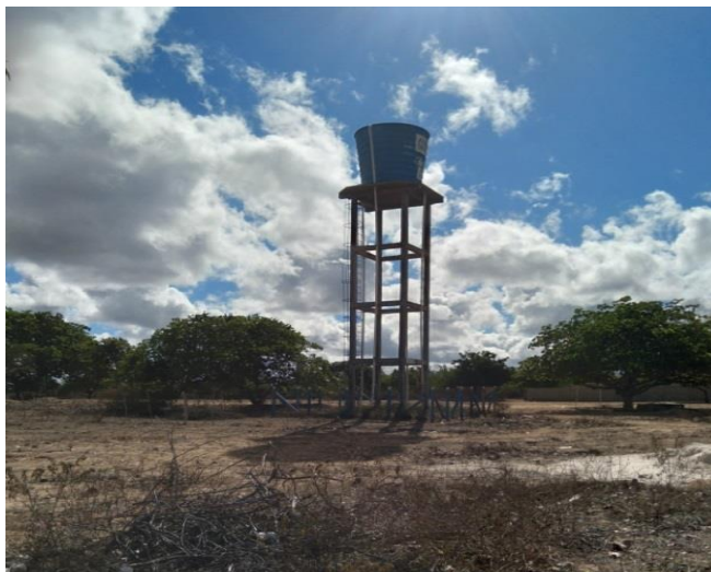
Figura 37: Caixa d'água do sistema de fornecimento de Água do povoado do Topo.
