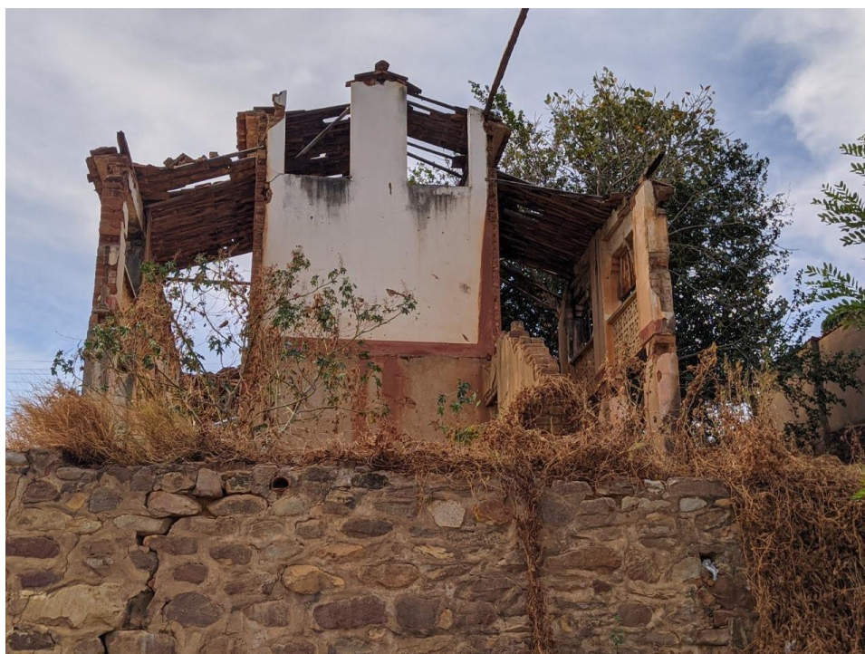
Fotografia 9 – Estrutura em pedra, indicando a construção anterior aos anos 1960.
