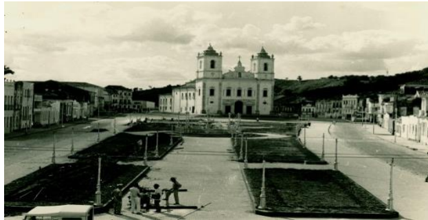
Figura 07 - Praça da Purificação (Santo Amaro) (Foto do ano 1856 quando foi instalado o chafariz)
