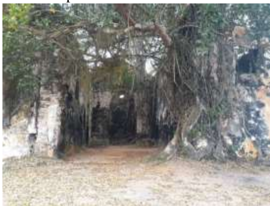
Figura 7 - Ruína da Igreja Senhor da Vera Cruz - parte interna.
