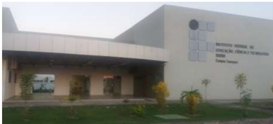
Figura 14: Visão da Faixada do IFBA Campus Camaçari
