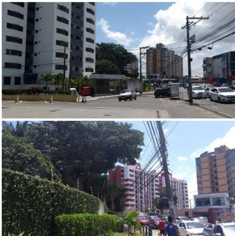
Imagem 5: Residências Verticais de Alto/Médio Padrão - Cabula
